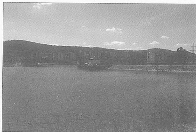
Obr. 3 – pohľad na hrádzu z návodnej strany
