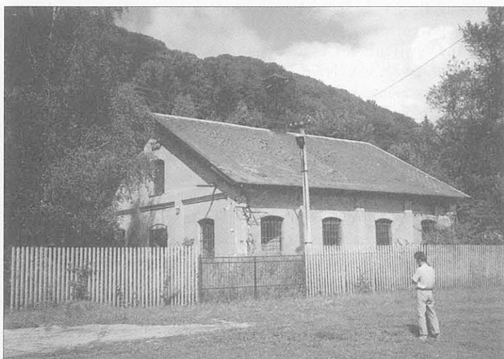
obr. 3: Budova bývalej MVE-Rožňava, časť Nadabudla, stav v roku 2006, mimo prevádzky
