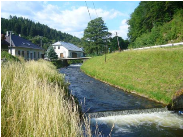
Obr. č.4. : P3 Intravilán – nevyhovujúci stav pod Hriňovskou nádržou – trávnaté kosené brehy, absencia vzrastlej brehovej vegetácie
