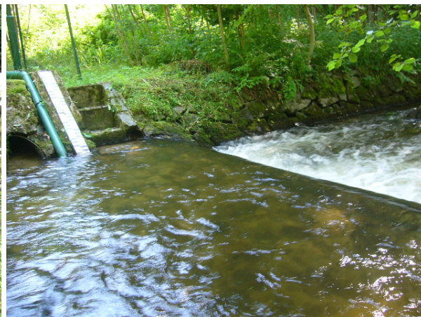
Obr. č.4. : P2 Extravilán – pred Hriňovskou nádržou prítomnosť dvoch stupňov a dvoch vpusť
