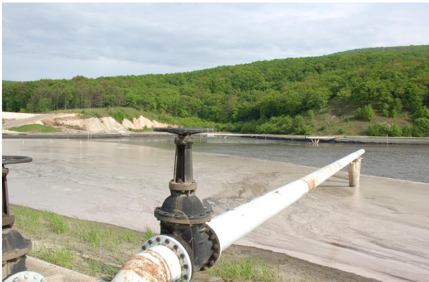
Obr.1 Hydraulický spôsob ukladania odpadov na odkalisko – naplavovanie
